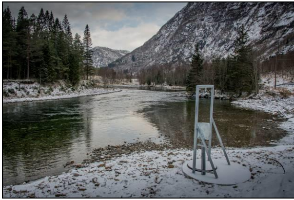
Figur 3 Modalselva med inntaksbrønn for kalkdoserar.
